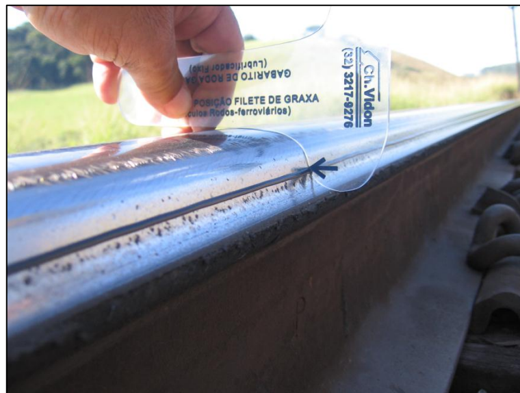
Figura 104: Verificação do filete de graxa com gabarito.
