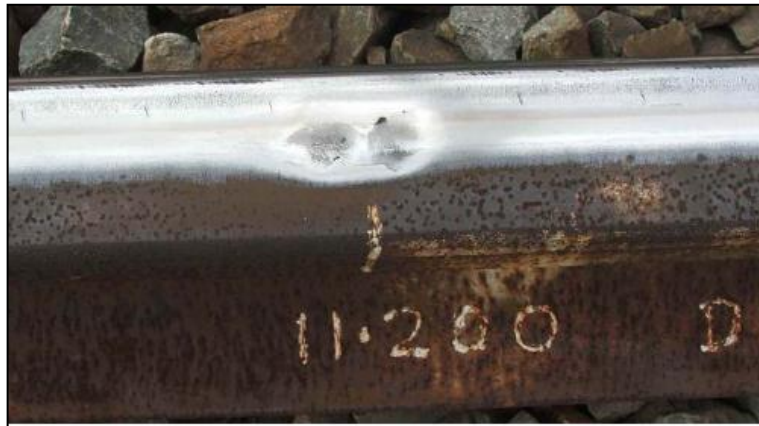
Figura 52: Defeito de squat na banda de rodagem do trilho.
